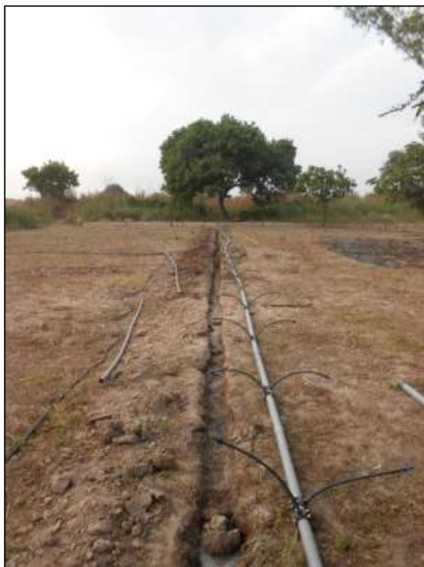
Figura 5: Instal·lació PVC 63
